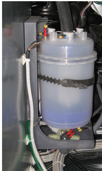
Figura 3.11: Collegamenti umidificatore
